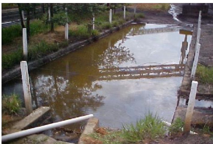
Figura 2. Tanque de captação e tratamento físico (MENEZES, 2002 p.12).
