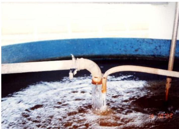
Figura 3. Tanque de equalização para neutralização do efluente (MENEZES, 2002 p. 14).
