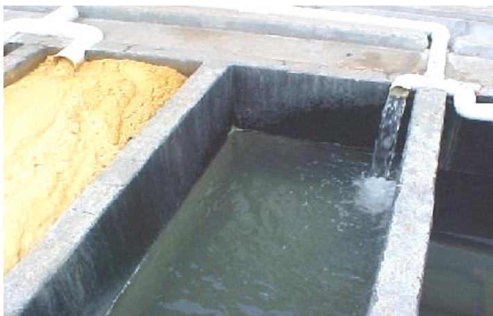
Figura 5. Efluente tratado com sistema FAD, com separação sólido-líquido (MENEZES, 2002 p16).
